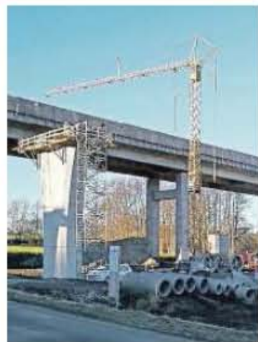
Un cantiere autostradale
